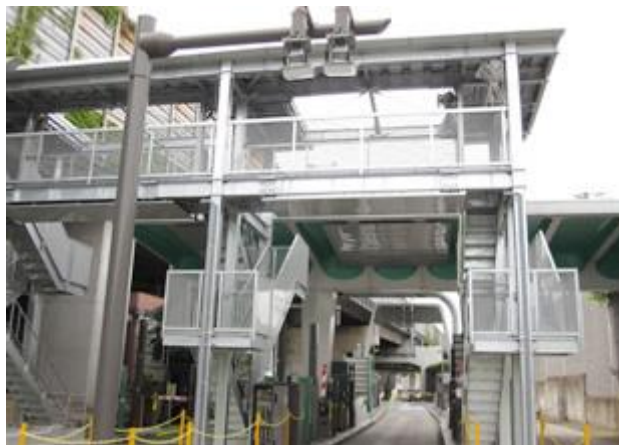
図 3-2-2 大屋根からの電波反射防止のために電波吸収体施工例 (出典：新日本電波吸収体 HP)
